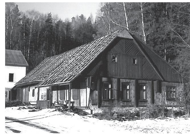
Budova hostince Lázně před zbouráním
